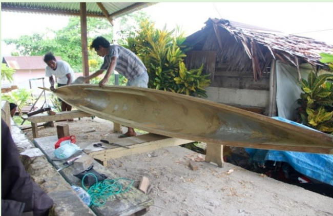
Een ‘prauw’ in aanbouw: de binnenkant is nu gereed.
